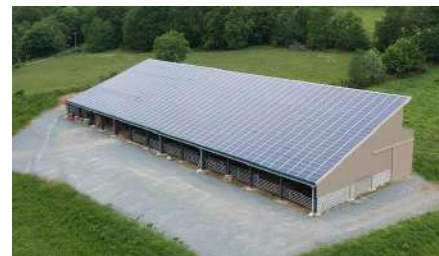
Exemples d'implantation de panneaux solaires sur les toitures de bâtiments agricoles
