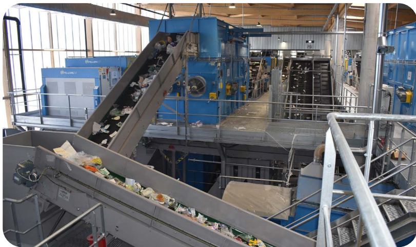
↑ Le tout nouveau centre de tri du Sietrem
