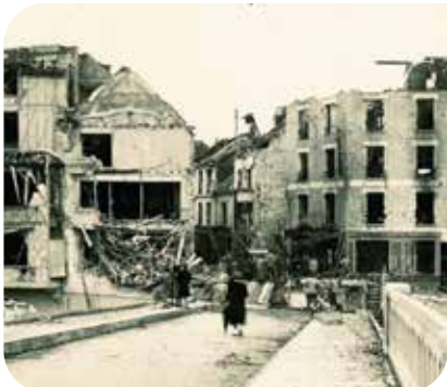
↑ Photo de destructions après la libération de Lagny, le 27 août 1944
